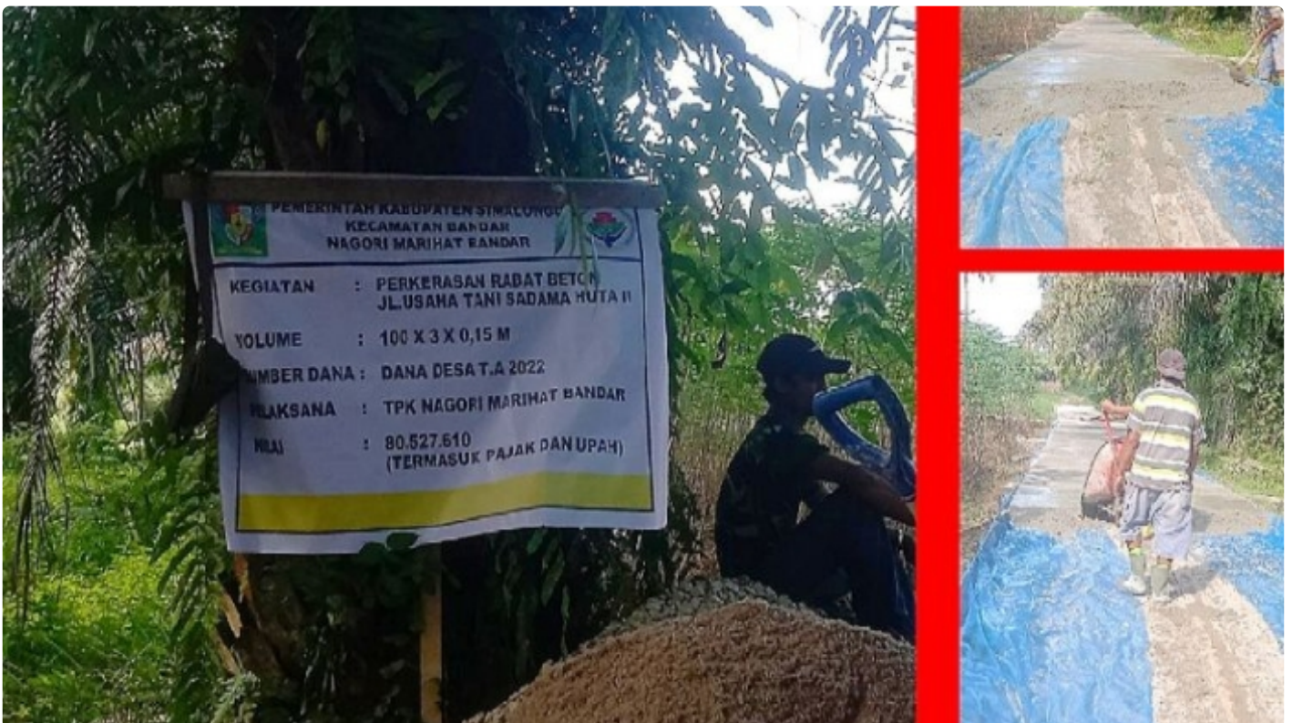
Keterangan Photo : Proses Pengerjaan Perkerasan Rabat Beton di Lokasi Jalan Usaha Tani Sadama, Huta II, Nagori Marihat Bandar, Kecamatan Bandar, Kabupaten Simalungun
